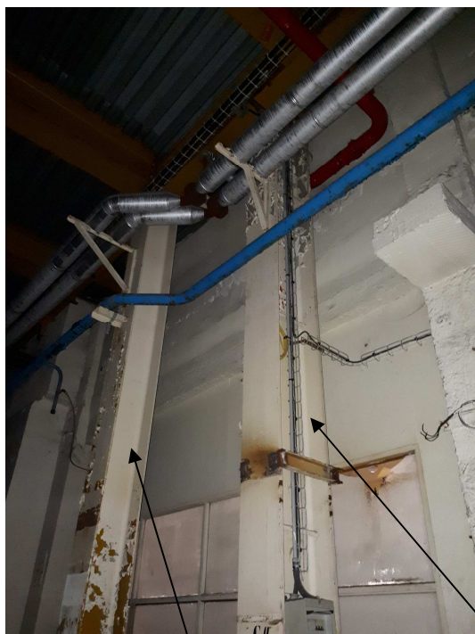
Structure recréée pour support de la mezzanine ajoutée
